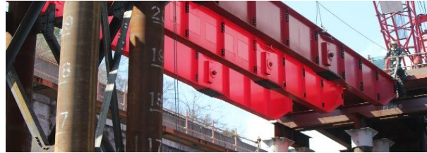
⑦主桁架設
