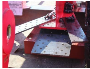
②プレート設置
