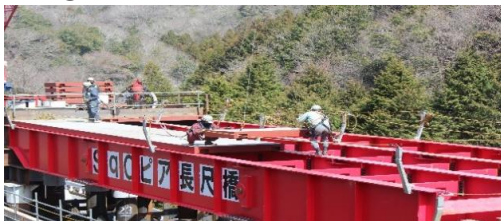
⑨覆工板敷設
