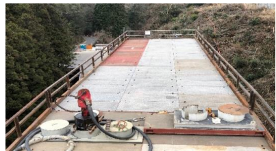
⑩手摺り設置
